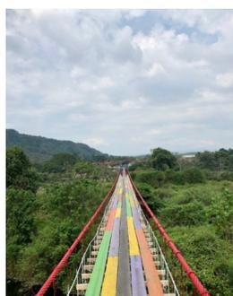
Jembatan Gantung Pagar Batu memiliki panjang 310 meter. Papan kayu sebagai alas pijakan disusun secara vertikal dari ujung ke ujung jembatan. Terdapat 5 kolom papan kayu yang tersusun. Pemasangan awal pada kolom ke 1,3 dan 5 dimulai dengan papan yang panjangnya 2,5 meter. Pada kolom 5, tiap papan diwarnai berbeda dimulai dengan warna merah, ungu, kuning, dan hijau. Pewarnaan di ulang seperti urutan diawal.
