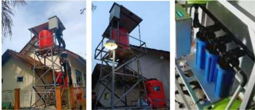
**Gambar 6.** Sistem SHS terintegrasi filtrasi air yang sudah terinstal di desa kalijaran dan telah menghasilkan minimal 1150 L air bersih setiap hari
