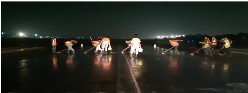
Gambar 5. Proses Penyikatan Landasan Pacu
