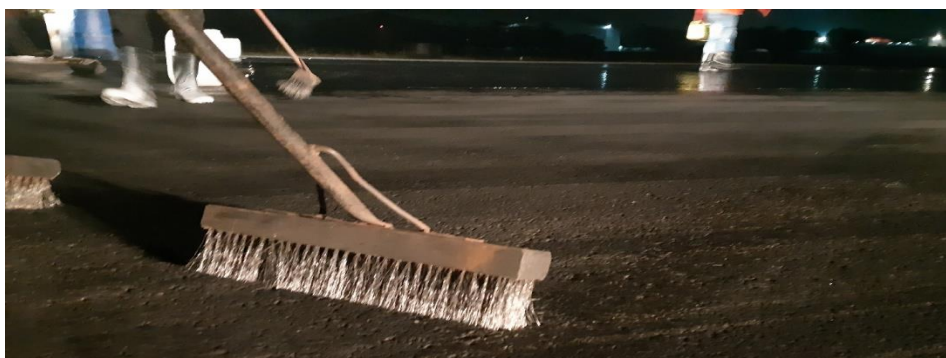
Gambar 6. Sapu/Sikat Besi yang Digunakan Untuk Menyikat Permukaan Landasan
