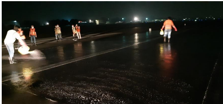
Gambar 4. Proses Penyiraman Permukaan Landasan dengan Chemical
