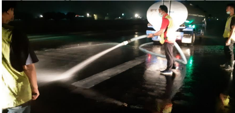
Gambar 7. Proses Pembilasan Permukaan Landasan Setelah Disikat
