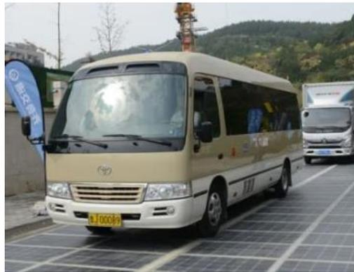
Gambar 5. Jalan yang Dipasangi *Solar Road Panel*
