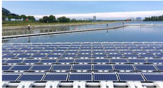
Gambar 6. Pemasangan Panel Surya di Perairan
